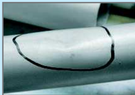
Eine Beule am Flügelrohr lässt sich im eingebauten Zustand nur schwer erfühlen, wenn sie hinter der Mylar-Anströmkante liegt.
